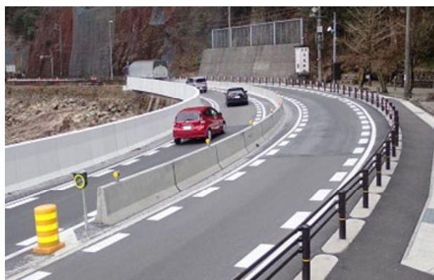
写真-1 保井戸地区における視距改良・中央分離帯設置
