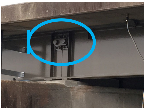
図－13 連結板による主桁連結状況
