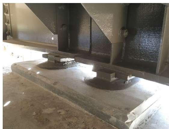
図-11 支承交換状況
