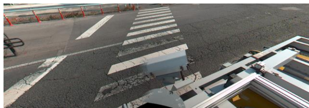
図-7 国道22号路面性状調査風景
