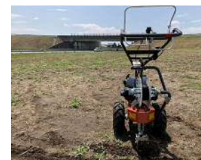
写真-5 ガイドワイヤー設置
