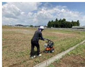
写真-4 境界ワイヤー設置
