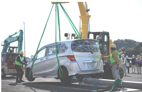
図-11 バックホウによる車両の吊り移動
