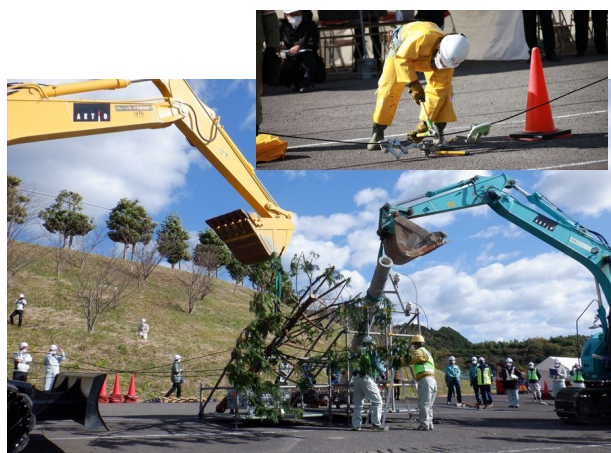
図-15 バックホウにより倒木と傾斜電柱を固定した上で電線切断処理
