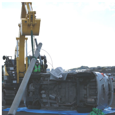
図-14 倒壊電柱の頭部吊り上げ・回転による撤去
