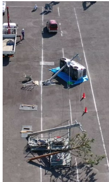
図-13 被災状況の設定(ドローン空撮)
