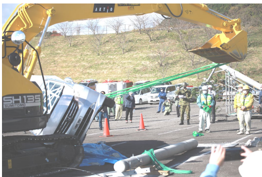
図-10 バックホウによる転倒車両の引き起こし
