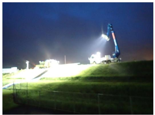
写真-3 排水ポンプ車による排水作業
