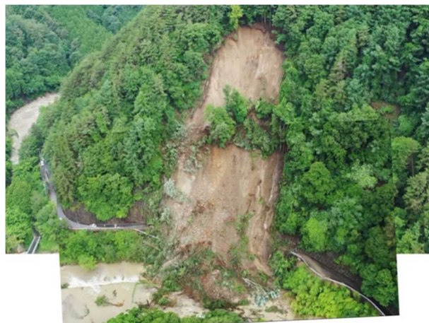
写真-1 崩落斜面全景(令和2年7月12日撮影)
