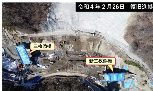
写真-7 5工区による復旧工事の施工状況
