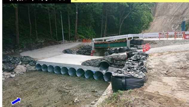
写真-5 潜り橋の完成
