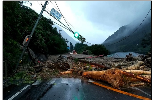
図-4 信号機被災状況 (②下河原)
