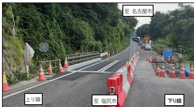
図-7 上り線側橋梁復旧の様子（①須原北）
