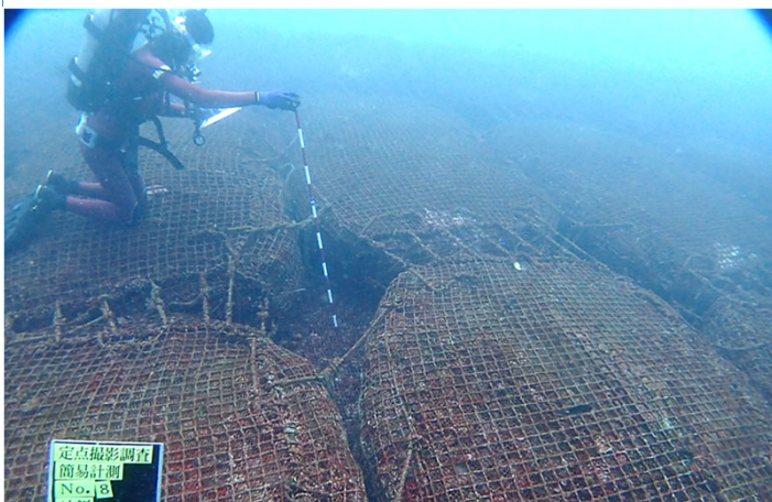
図-5 現地調査の様子
