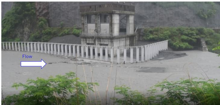
呑口部バイパス運用直後の状況 (6/30 16時頃 流入量約100m<sup>3</sup>/s 約EL614m)
