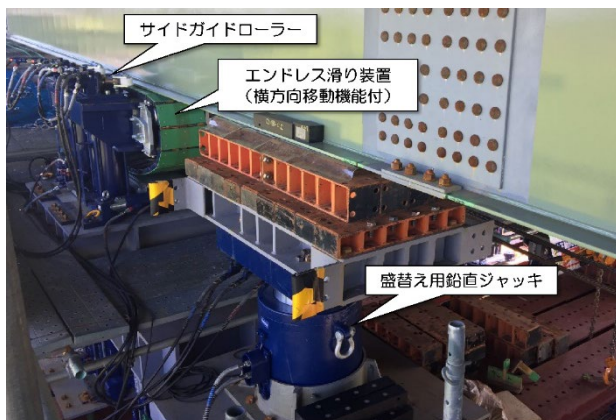
図-13 軌道修正装置
