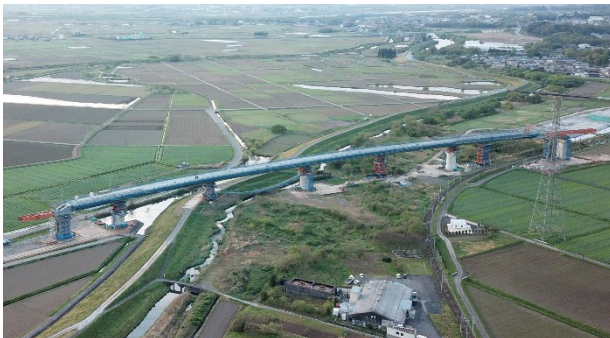
写真-2 送出し架設完了
