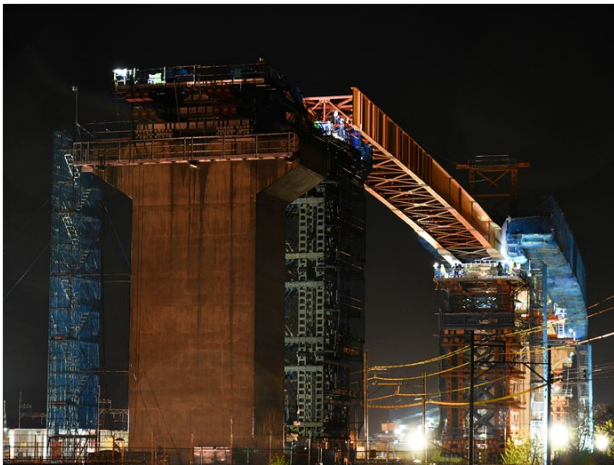
写真-1 夜間送出し状況（送出し5回目）
