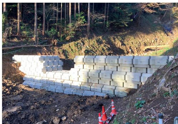
写真-8 仮設堰堤（コンクリートブロック）
