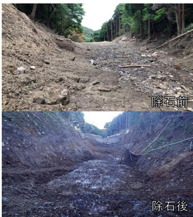
図-4 既設堰堤除石前（上）と除石後（下）の比較
