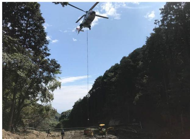
写真-6 ヘリコプターを用いた土砂の搬出
