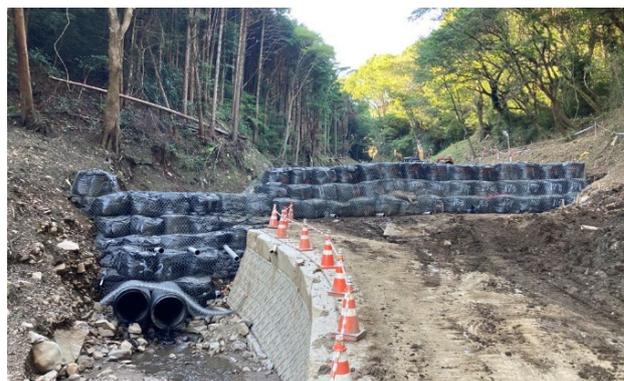
写真-7 仮設堰堤（ネットロール土のう）
