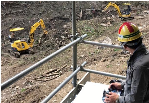
写真-10 無人化バックホウによる既設堰堤の除石作業状況
