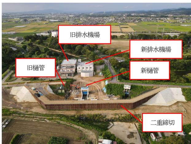
本工事は、愛知県の湛水防除事業で、既設排水樋管の改築について受託をしている工事で、鋼矢板で二重締切をつくり、堤防開削をして、新しい樋管をつくる工事です。堤防天端は市道となっていますが、堤防開削のために通行規制が必要な工事でした。
