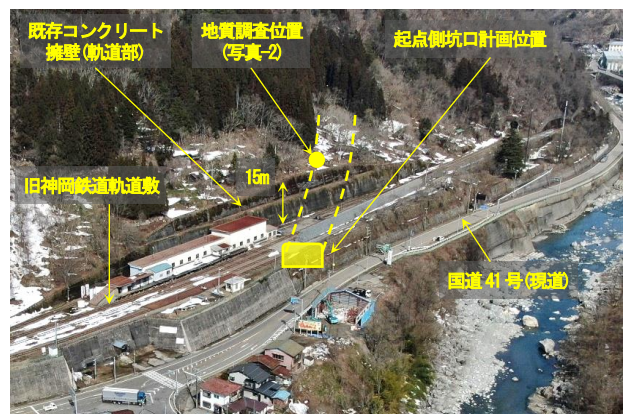
写真-1 起点側坑口部の地形状況
