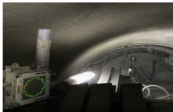
写真-2 警告ランプ設置状況
