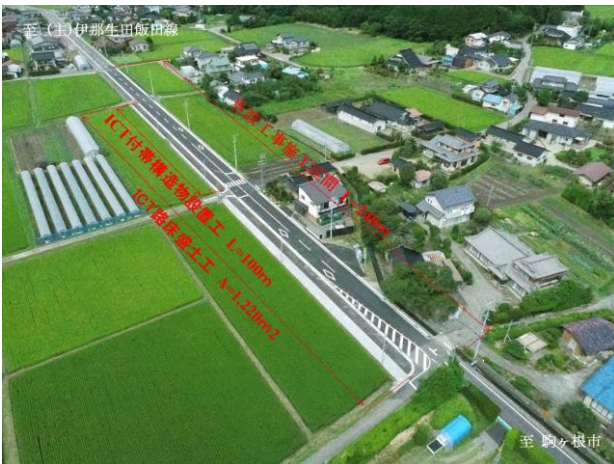
写真-3.1 完成後（上空からのぞむ）
