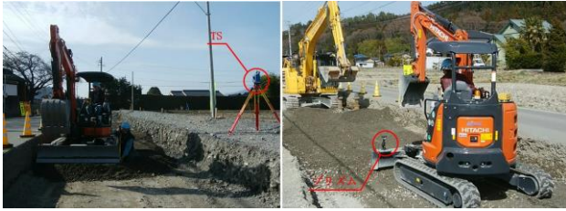
写真-3.3 TSを用いた敷均し状況
