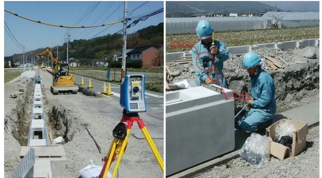
写真-3.6 TSを用いた排水構造物工の据付状況
