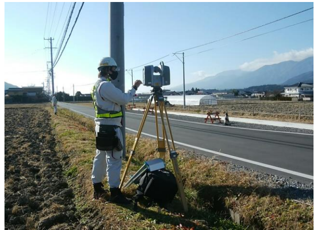
写真-3.2 3次元起工測量状況
