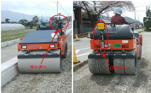
写真-3.4 GNSSを用いた転圧状況
