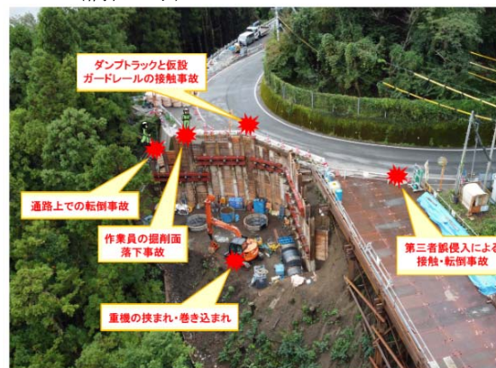
図-5 空中写真を取り入れたハザードマップ 2 (橋台工事)
