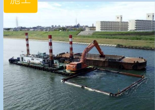
3次元設計データに従いマシンガイダンスで掘削
