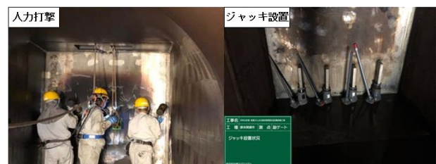
図-2 応急対応状況
