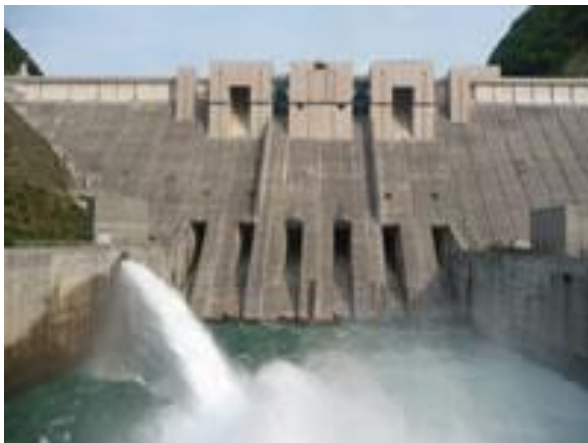
図-1 長島ダム正面写真
