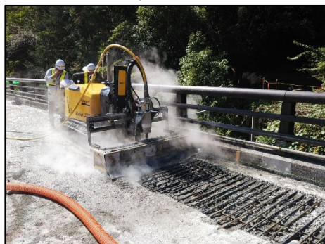
写真-3 ウォータージェットはつり処理工法
