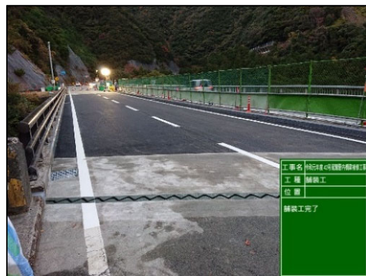
写真-5 舗装・区画線工完了状況(R2.12.19撮影)
