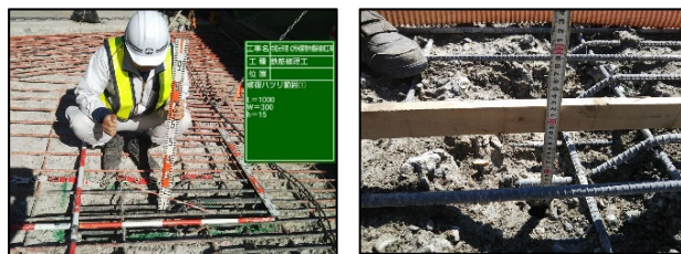
写真-4 はつり後の床版状況確認
