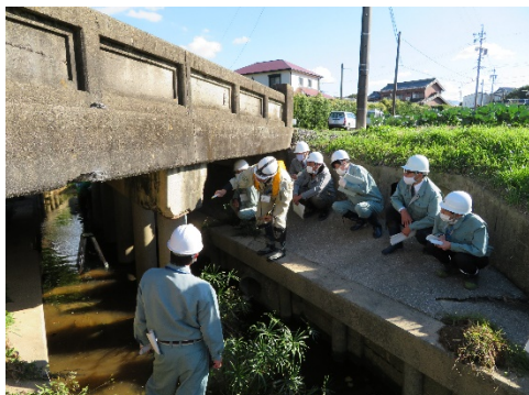
図-3 職員向け点検講習会の様子（愛知県田原市）
