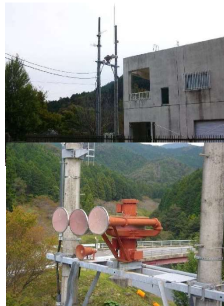
図-4 既設サイレン（上：遠景，下：近景）
