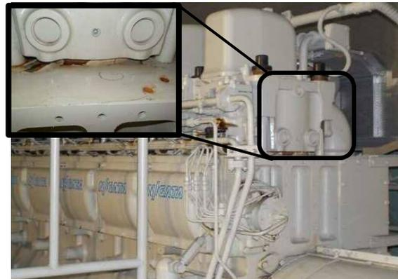
写真3.1 荒子川ポンプ所エンジン4号機漏水状況
