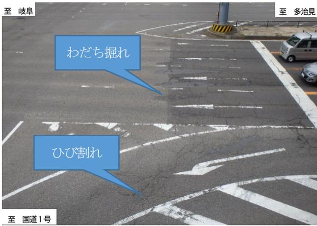
写真-1 日銀前交差点の損傷状況 (2018年撮影)
