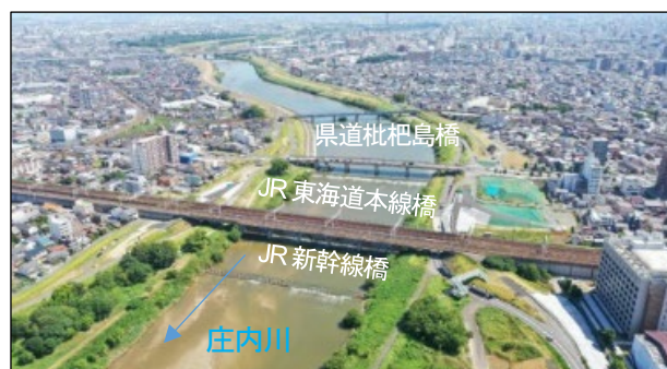
図-5 橋梁改築（JR新幹線橋等3橋）
