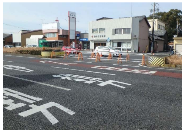
図-10 バリケードによる仮閉鎖。
