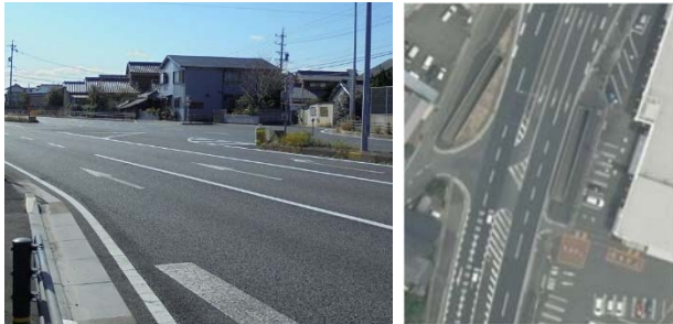
図-1 右折レーンが設置された開口部（津市栗真小川町）。
