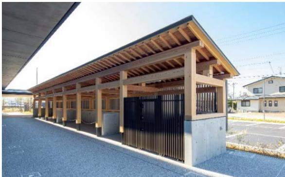
写真-2 自転車置き場C（軸組構法・軸構造系）
