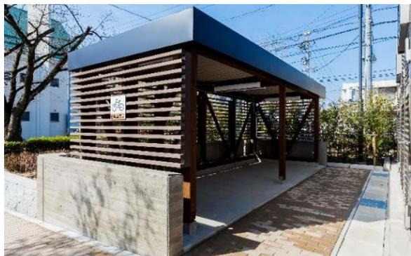
写真-3 自転車置き場D（軸組構法・壁構造系）
