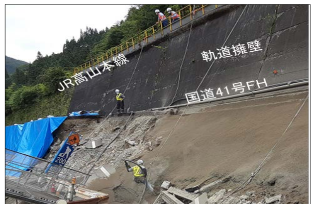
図-1 軌道擁壁基礎部の安定化の様子
