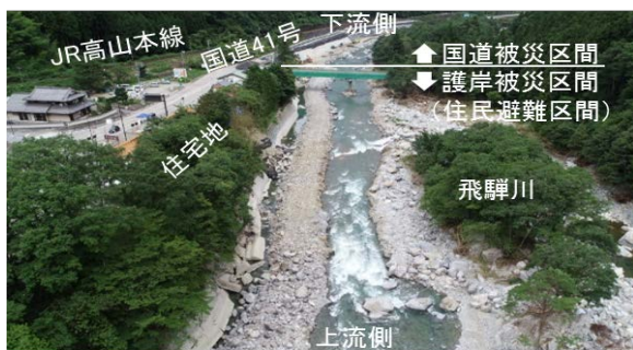
図-3 国道・河川護岸一体の瀬替え
