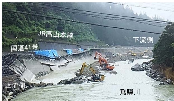
図-2 右岸河床掘削による瀬替え
