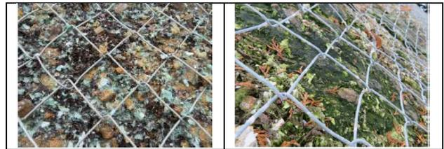
写真-2 試験施工区の拡大写真(左:施工直後, 右:BSCの形成, 施工後1カ月後)
