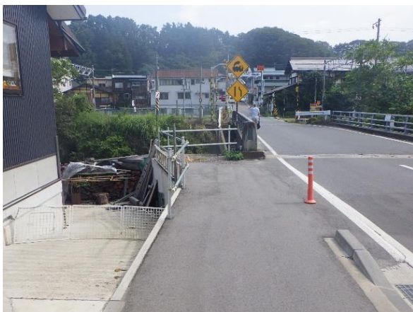
図-4 着工前 現場写真(左岸より)
