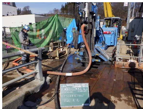
図-6 構台を使用している様子
