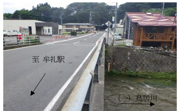
図-2 着工前 現場写真（右岸より）
