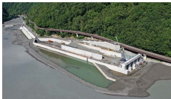
写真-3.1 スtockヤード施設施工状況 (R2年6月)
