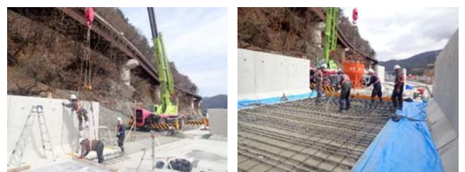
写真-4.1 プレキャストL型（左）と現場打ち底版コンクリート（右）の施工状況
