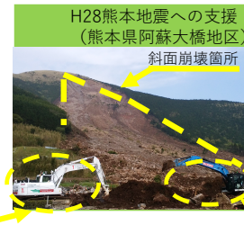
無人化施工BH（中部地整）
