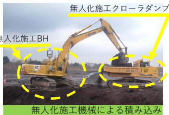
無人化施工クローラダンプ
