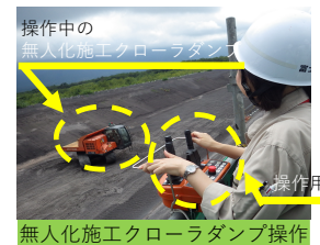
無人化施工クローラダンプ操作
