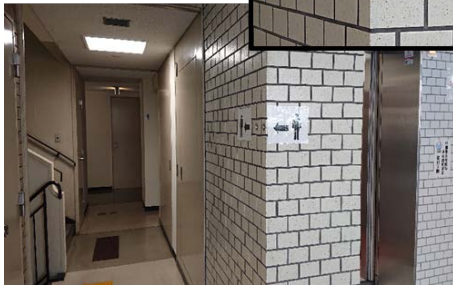
トイレへの誘導表示
