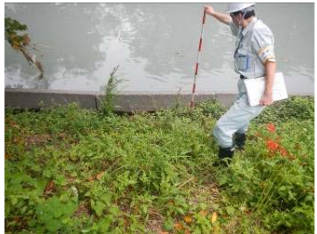
写真-1 点検の実施状況
