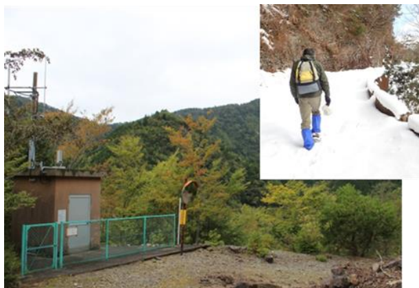
（図-7）父ヶ谷雨量観測所 巡視点検状況
