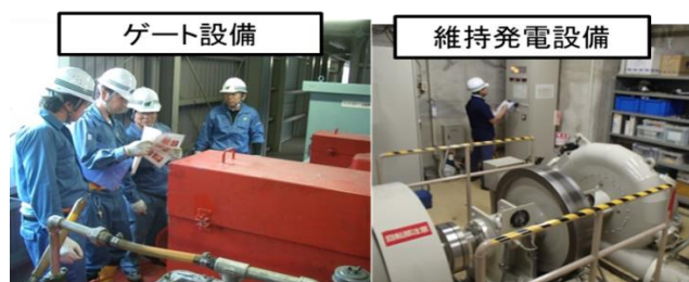
（図-9）その他 巡視点検状況
