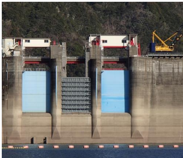
(図-17) 2号クレストゲート工事状況
