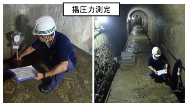
（図-10）観測作業状況（揚圧力測定）
