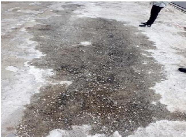
図-3 床版面の土砂化状況（寺の前2号橋）
