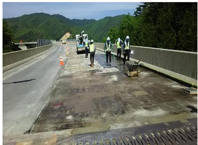
図-6 彦谷橋 防水層塗膜（施工中）
