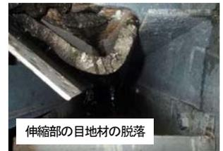
写真-2 伸縮装置の損傷状況
