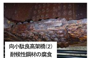
向小駄良高架橋(2) 耐候性鋼材の腐食
