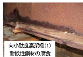
向小駄良高架橋(1) 耐候性鋼材の腐食
