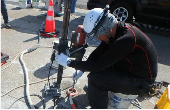
写真-9 RMA 工法施工状況(削孔)
