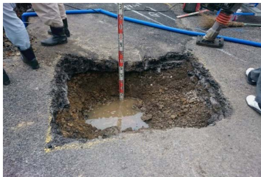
図-4 漏水状況
