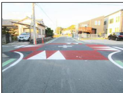
図-7 設置した交差点ハンプ
