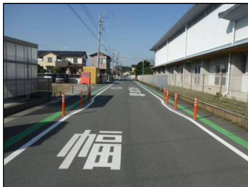
図-9 設置した道路狭窄
