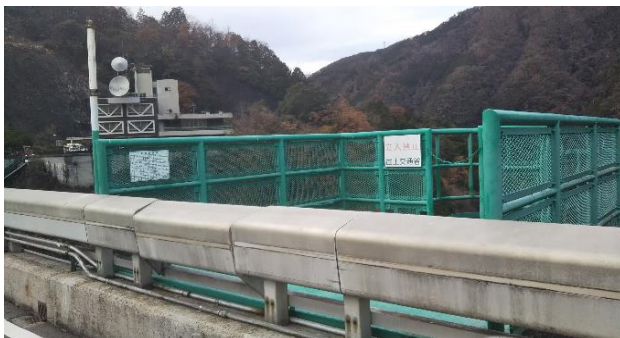
図-4 堤体中央付近
