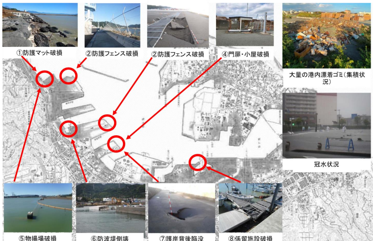
図-5 清水港の被害発生状況
