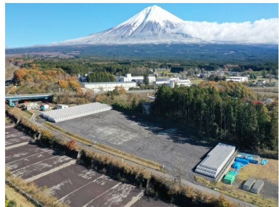
図-5 静岡県富士宮砂防出張所裏のブロックヤード
