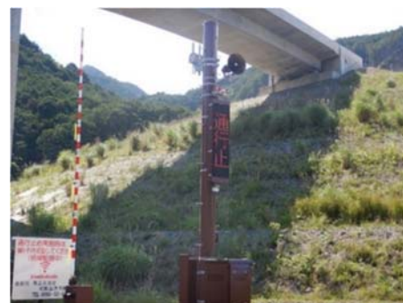
写真-3 放送設備（ゲート起終点に設置）
