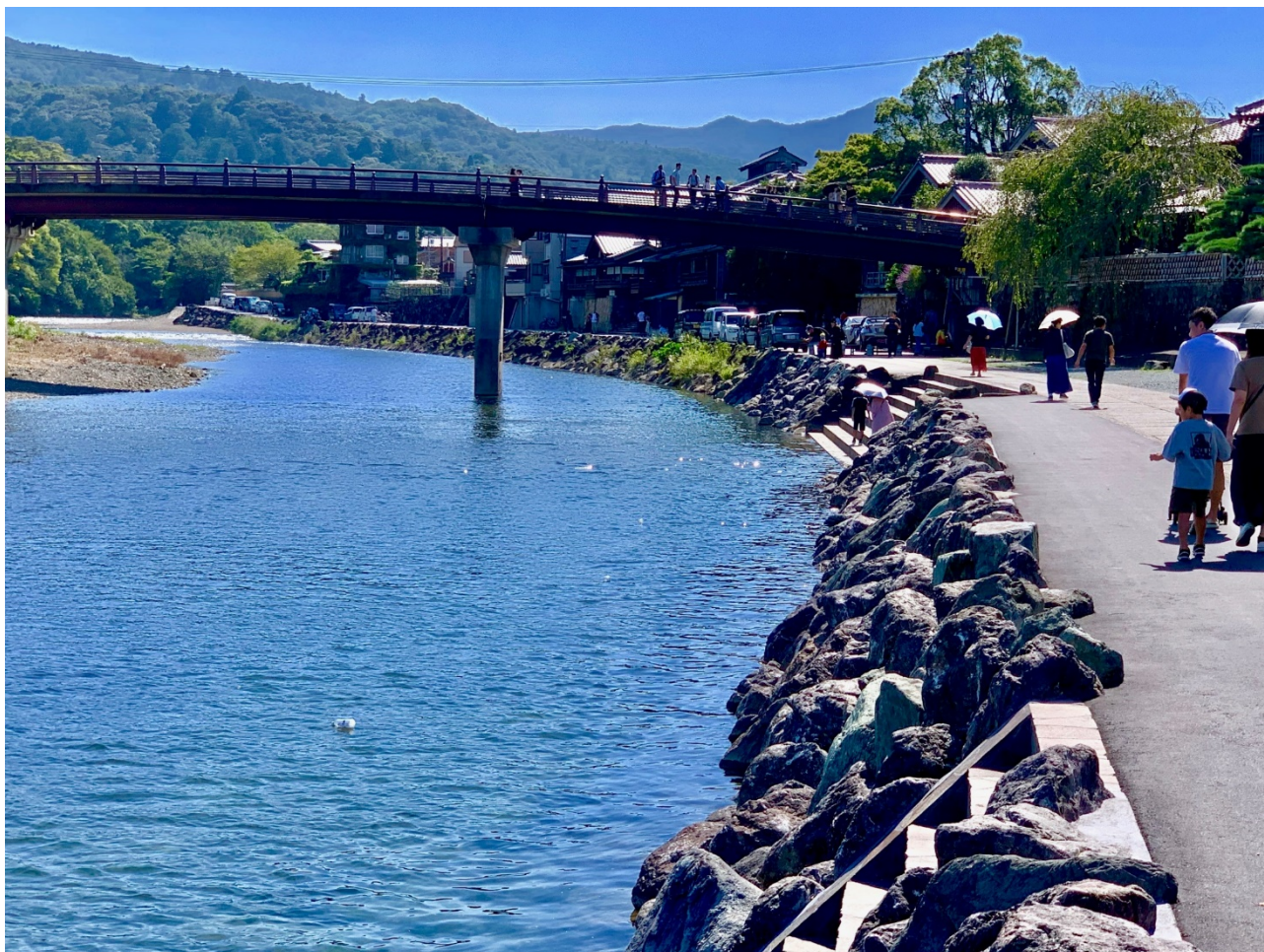
写真-7 完成後の状況
