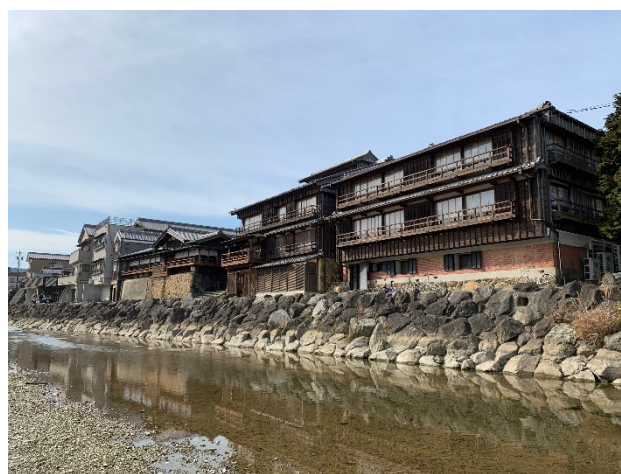
写真-5 護岸整備状況（自然石）
