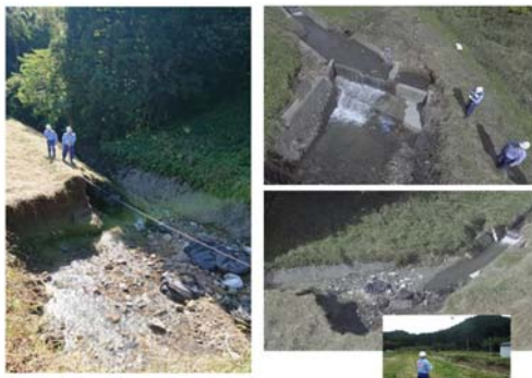
図-4-2 R1 台風19号 宮城県岩沼市志賀沢川調査 (豊橋河川・設楽ダム工事事務所から派遣)
