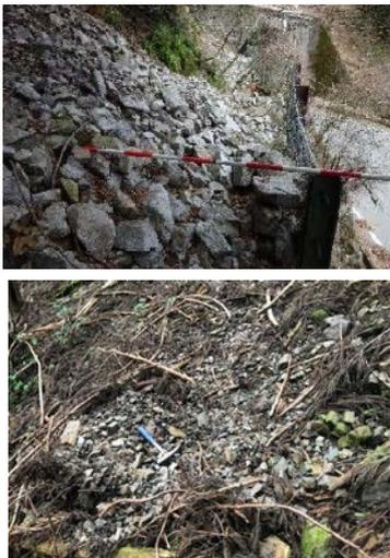
図-9 現道沿い防護柵背後の落石の堆積状況(上)と切土区間の落石堆積物(下)の状況
