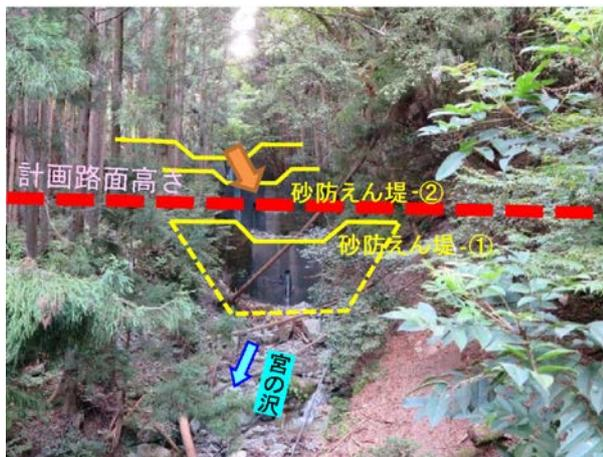
図-8 土石流による土砂流入が懸念される箇所
