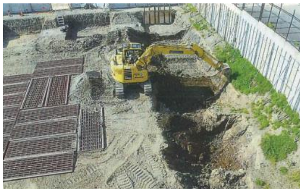
写真-4 ICT建築土工の掘削状況
