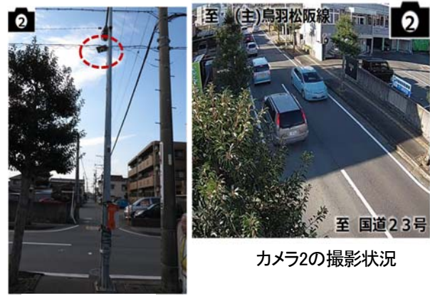
カメラ取付状況
