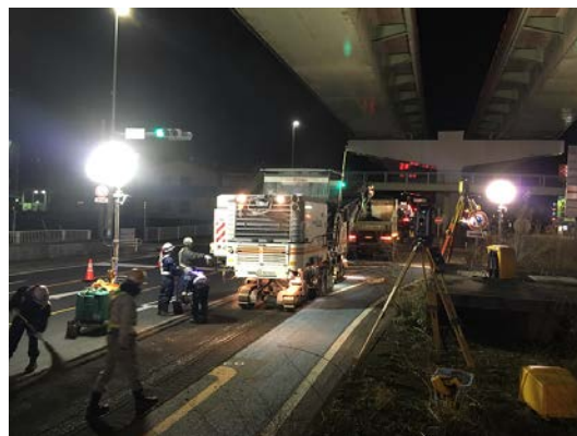
図-5 TS式MGによる切削工の実施状況
