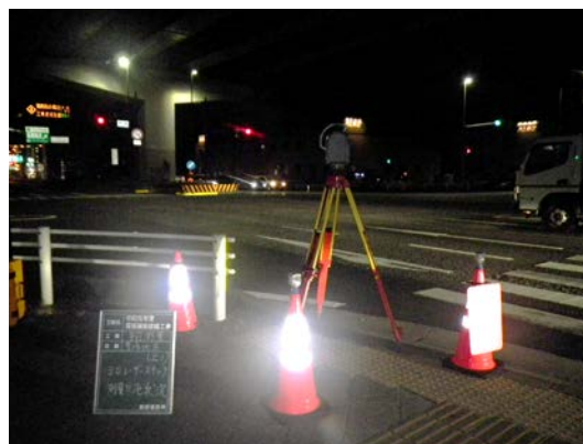
図-3 TLSによる3次元起工測量の実施状況
